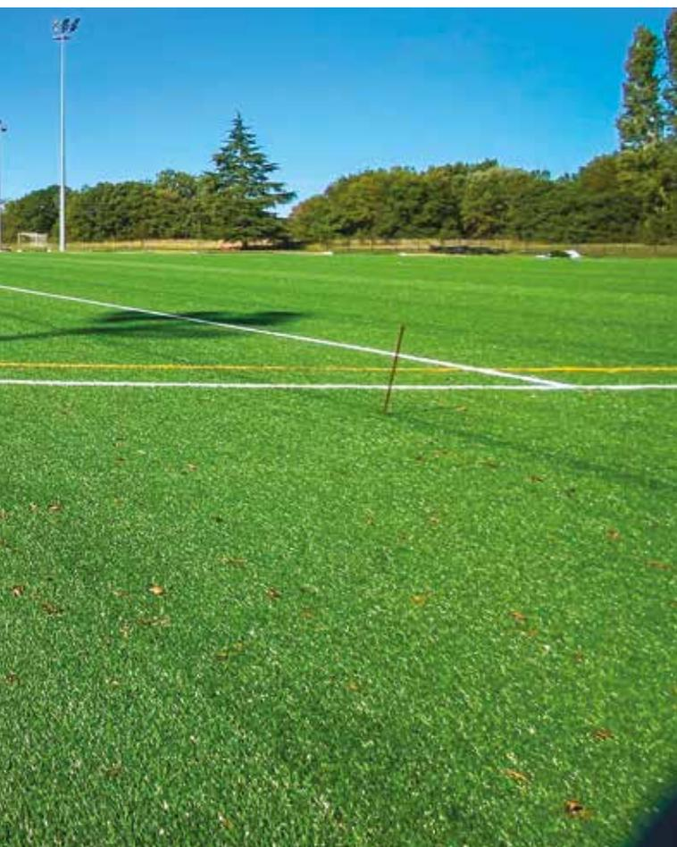
La sous-couche de souplesse amortissante ainsi que la fibre synthétique sont recyclées en fin de vie, le sable de remplissage et le liège stabilisateur sont eux des produits naturels.
